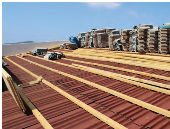
▲ Solidité accrue pour la Onduline® Flexoutuile T470 qui autorise la marche sur la plaque, assurant confort et grande sécurité lors de la pose.
