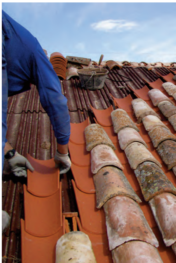
▲ Solidité accrue pour la Onduline® Flexoutuile T470 qui autorise la marche sur la plaque, assurant confort et grande sécurité lors de la pose.
